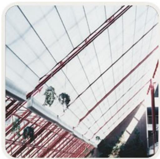
Для производства системы «Зимний сад» используются комплектующие применяемые в системах горизонтальных раздвижных карнизов: алюминиевый профиль, перфорированная лента или зубчатый ремень, электродвигатели. Дополнительно для системы «Зимний сад» разработаны роликовые штанги, направляющая штанга для мастер-глайдеров, а также механизм привода системы от одного электродвигателя.
